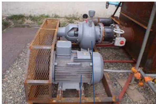
45KW6P 電動機 インバータによる 変速運転
